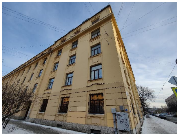
Иллюстрация 8. Проспект КИМа, 5/34. Архитектор Ф. И. Лидваль 1912-1914гг. (корпус, выходящий на переулок Декабристов достроен в 20-х)
